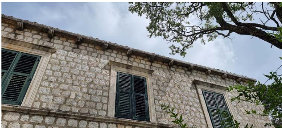
3. Kameni kanal, južni dio glavnog (SZ) pročelja
