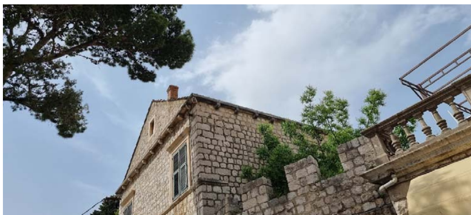
4. JZ (zabavno, ulično) pročelje s kontinuiranim kamenim kanalom, dimnjak
