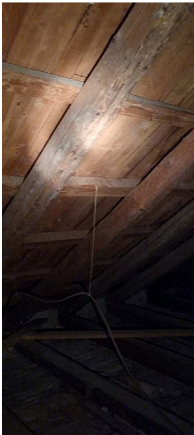
9. Postojeća krovna konstrukcija
